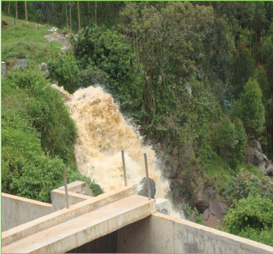
Unité de Micro hydroélectricité à Butaro, Burera District
